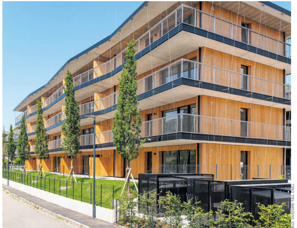
Gepflanzt sind Bäume, Sträucher, Kletterpflanzen und Kiwis an der Fassade.
