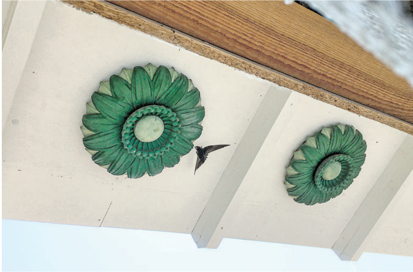
Mauersegler nisten in den Blechblumen des Otto-Wagner-Schleusengebäudes in Wien.
