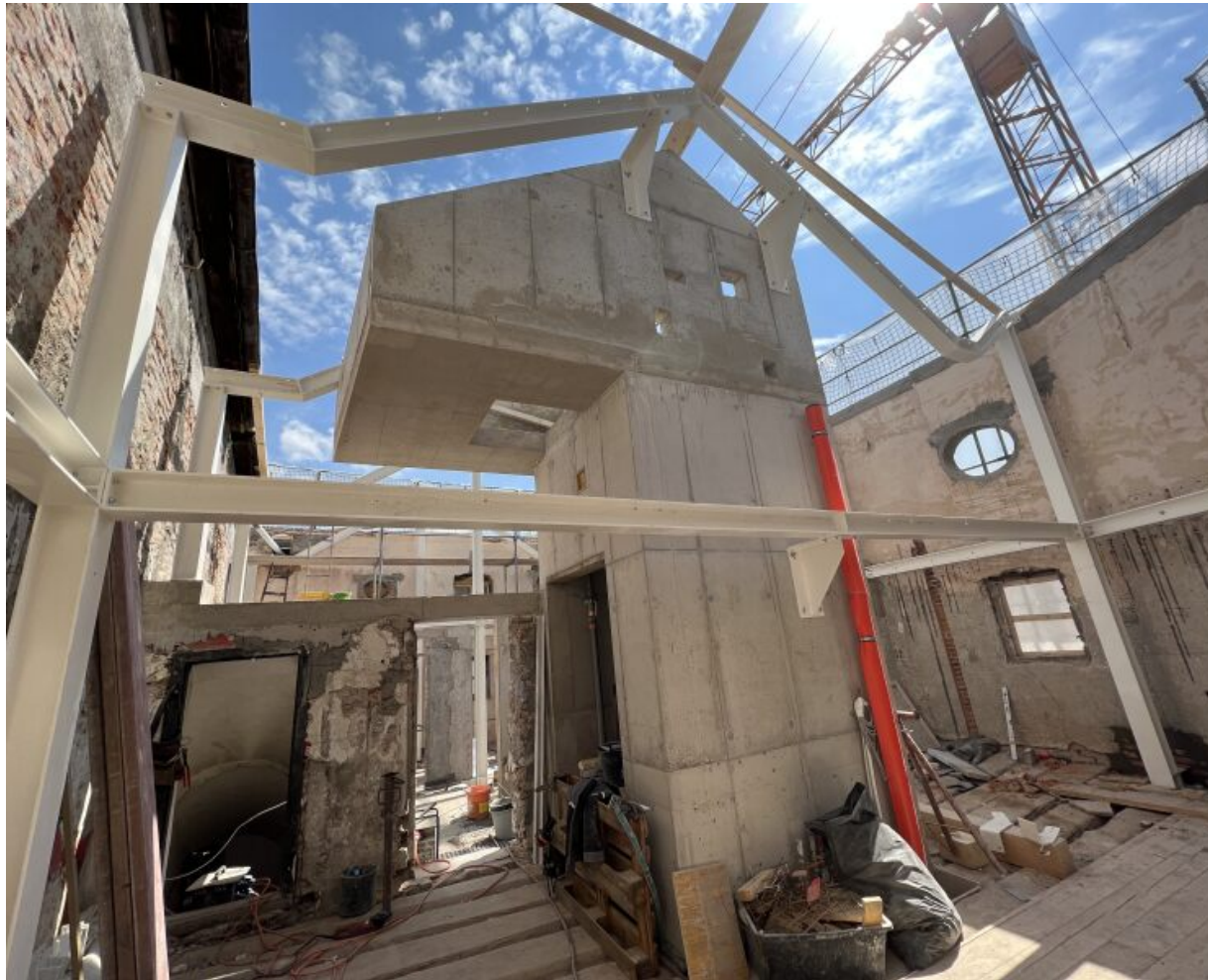
Linkes Bild: Das neue Foyer mit Stuckdecke. Mitte: Der Liftschacht ist die moderne Wirbelsäule des Hauses und fand noch innerhalb des Satteldaches Platz. Rechtes Bild (oben): Skizze für die Idee des Stahlgerüsts. Rechtes Bild (unten): Sanierter Außenansicht mit neuen Ochsenaugen.
