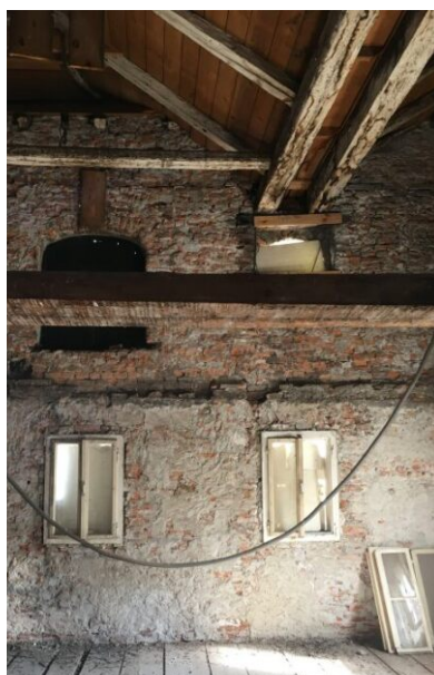
Linkes Bild: das alte Grabendach, erneuert mit Stahlkäfig und Faltdachkonstruktion (rechtes Bild).
